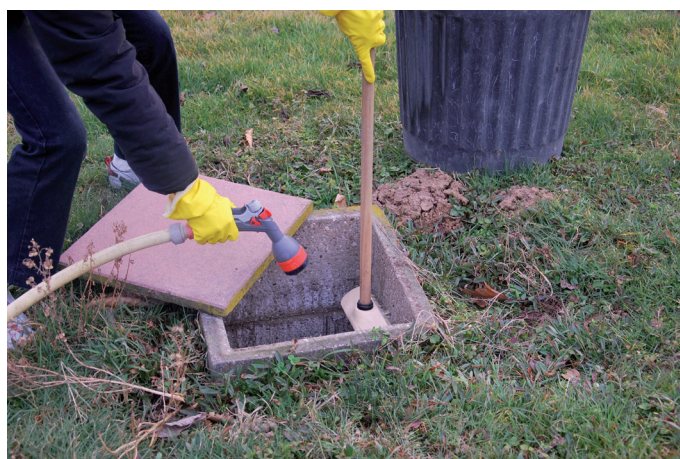
Nettoyage périodique des regards de visite
