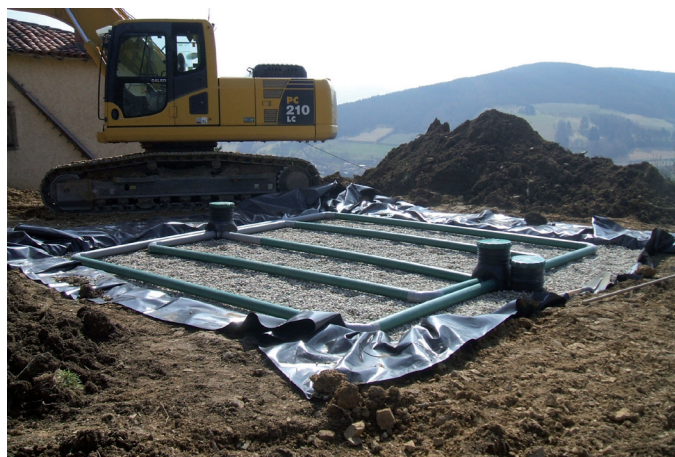
Travaux de réalisation d'un filtre à sable
