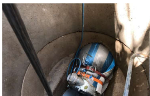
Gainage du collecteur amont de la station des Arthauds
